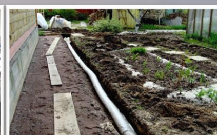
ตรวจสอบระบบระบายน้ำ
